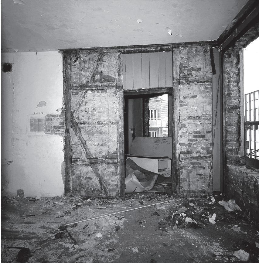
Veggkonstruksjoner i utmurt bindingsverk.
